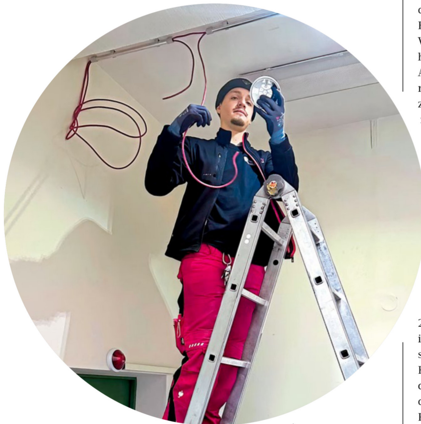
Azubi Nick Sperling (nicht verwandt mit den Firmeninhabern) bei der Installation von Brandmeldern
